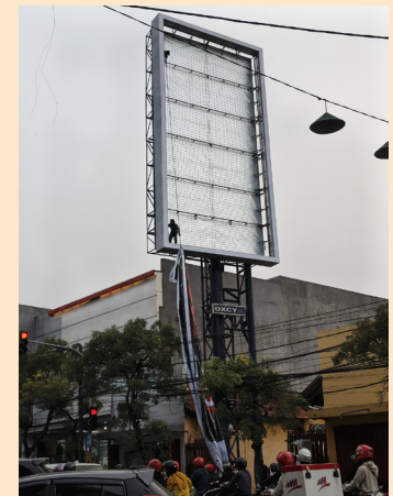
Pekerja Papan Baliho
